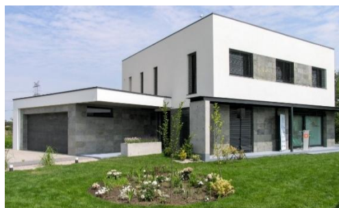
Rysunek 1: Widok ogólny budynku, elewacja południowa i zachodnia, źródło: KAPE
